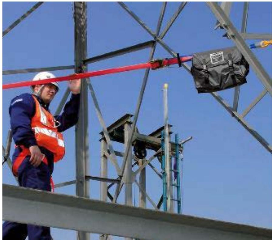
Wenn Sie bei der Arbeit in der Höhe häufig den Standort wechseln, müssen Sie Ihr Sicherungssystem immer wieder neu anbringen. Der HSL macht es Ihnen leicht: Sie spannen den Horizontalgurt zwischen zwei Haltepunkten, mit der Ergo-Zugratsche legen Sie eine Vorspannung an. Das lose Gurtende verstauen Sie in der Transporttasche – eine Stolperfalle weniger. Sie gewinnen Bewegungsfreiheit über die gesamte Länge des Sicherungsgurtes.
