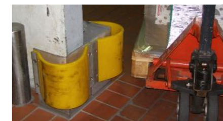
Ochrana proti najetí do betonových rohů
