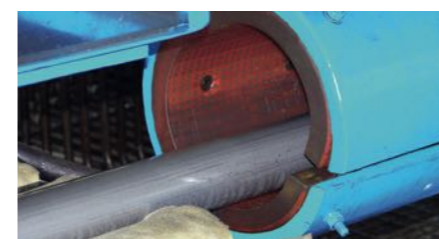
Obložení linky na srovnávání trubek
