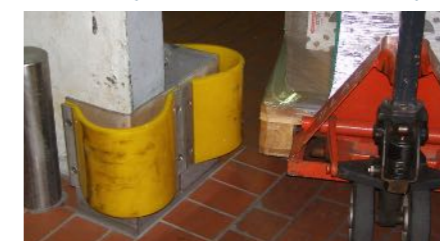
Ochrana proti najetí do betonových rohů
