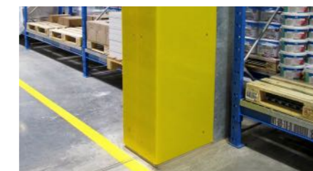
Ochrana proti najetí do betonových pilířů
