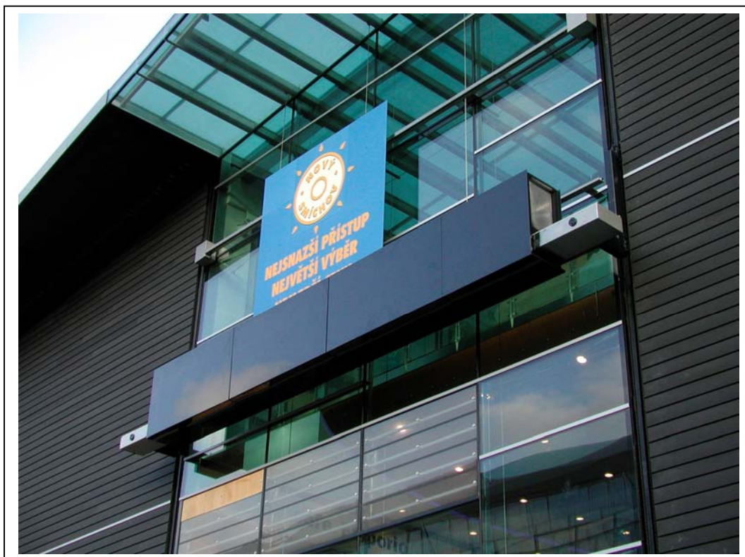
Obslužná lávka na průčelí obchodního centra TESCO v Praze Nový Smíchov
