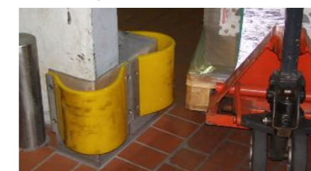
Ochrana proti najetí do betonových rohů
