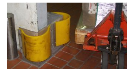
Ochrana proti najetí do betonových rohů
